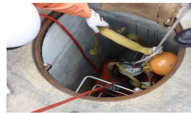
堅穴への転落を想定した救出訓練
