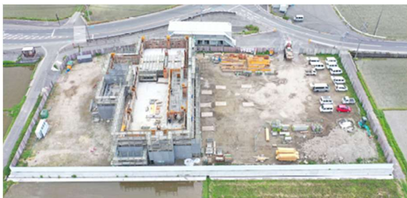
【建築現場写真】
