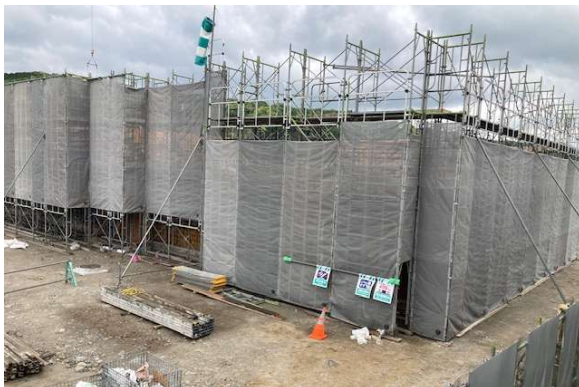
【建築現場写真】
